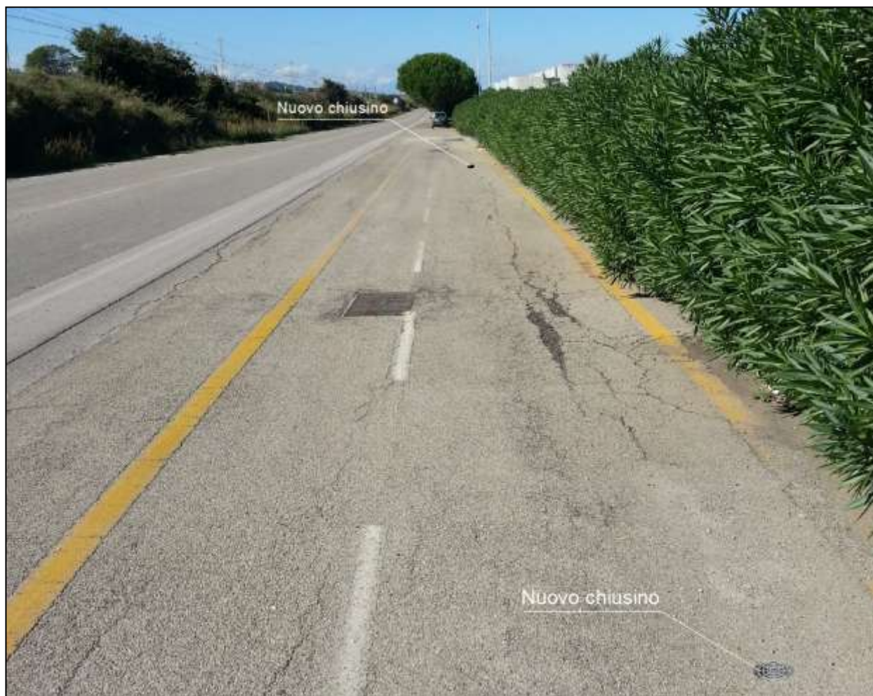
Immagine con evidenza nuovi chiusini
